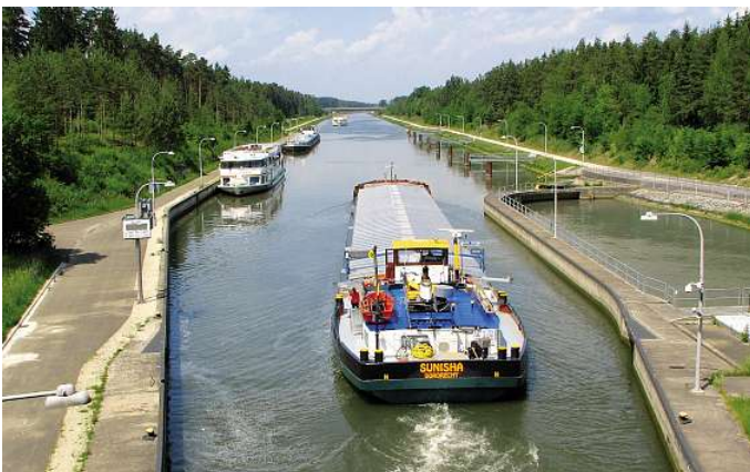
Die Sparschleuse Leerstetten bei Kanal-km 84,32 verfügt mit 24 m über die größte Hubhöhe, die Kammerbreite beträgt 12 m
