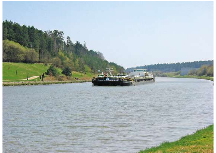
Scheitelhaltung bei Hilpoltstein: Hier überwindet die Wasserstraße die europäische Hauptwasserscheide von Rhein und Donau
